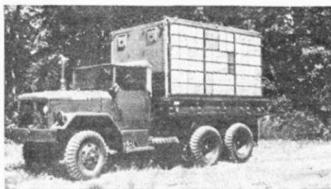
Рис. 6. Американская фотоэлектрическая установка, смонтированная на 2,5-т автомобиле
